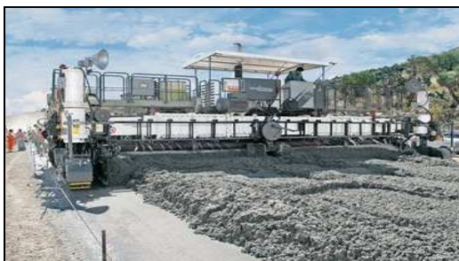
Abbildung 2: Aufnahme und Verteilung von Beton [151]
