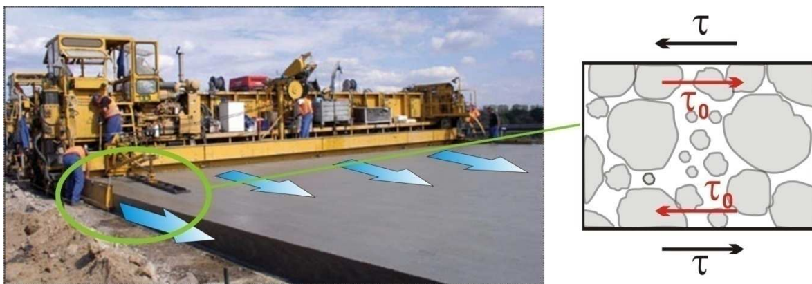
Abbildung 6: Reibungskräfte zwischen betonierten Fahrbahnplatte und Gleitschalungsfertiger [151]
