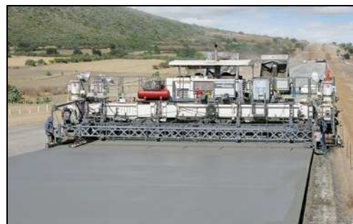
Abbildung 3: Verdichtete und gefertigte Fahrbahnplatte [151]
