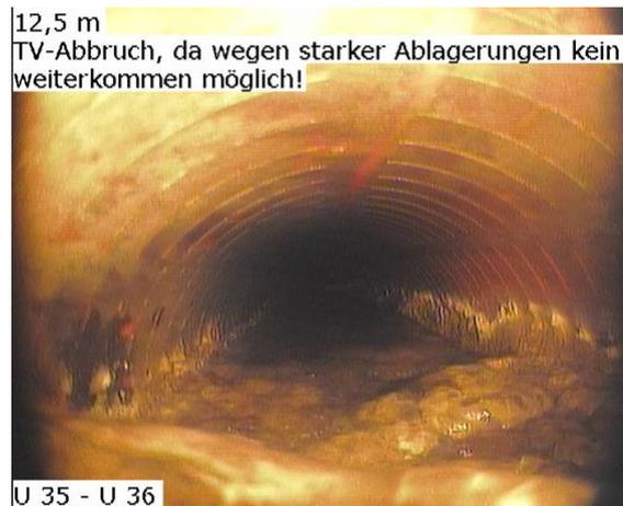
Abbildung 7: Drainageleitung mit Versinterung [24]
