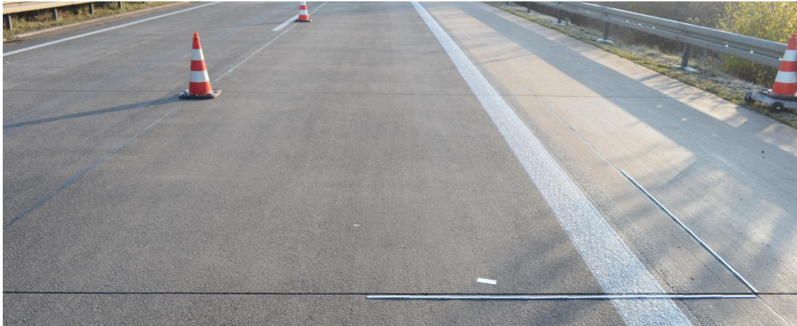
Abbildung 58: Beispielhafter Zustand eines Streckenabschnitts, der anhand beider Verfahren in Kategorie 0 eingestuft wurde. AKR-spezifische Schadensmerkmale waren nicht erkennbar, Risse konnten nicht festgestellt werden.
