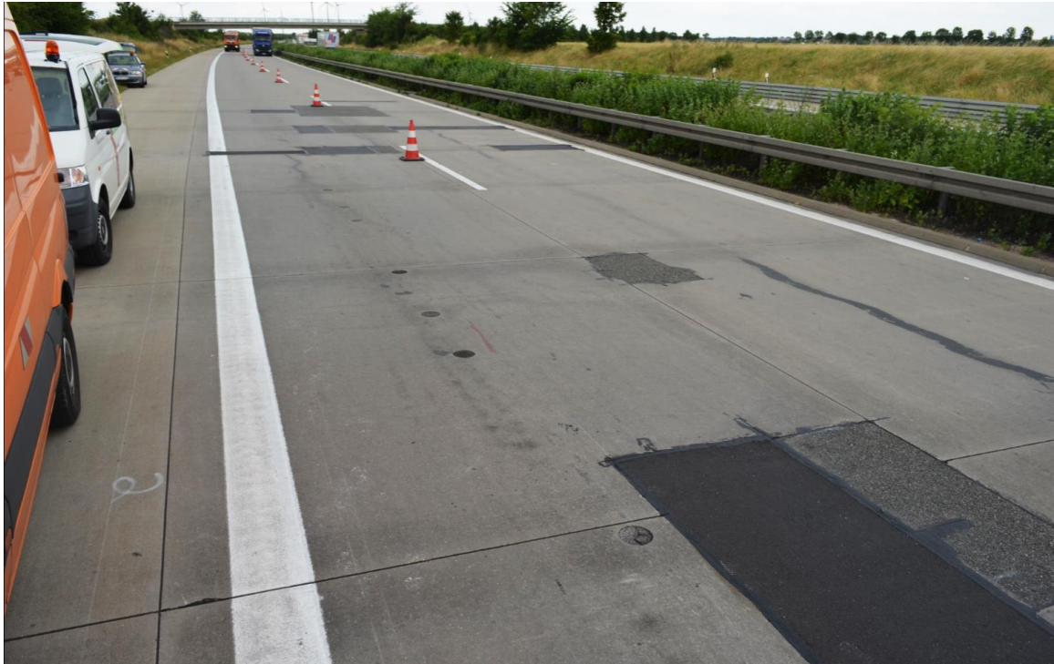
Abbildung 61: Beispielhafter Zustand eines Streckenabschnitts, der anhand beider Verfahren in Kategorie III eingestuft wurde. Neben deutlichen Verfärbungen lag eine besonders stark ausgeprägte Rissbildung mit Kantenschäden, Eckabbrüchen und lokalem Substanzverlust vor, Teilbereiche waren ausgebessert worden
