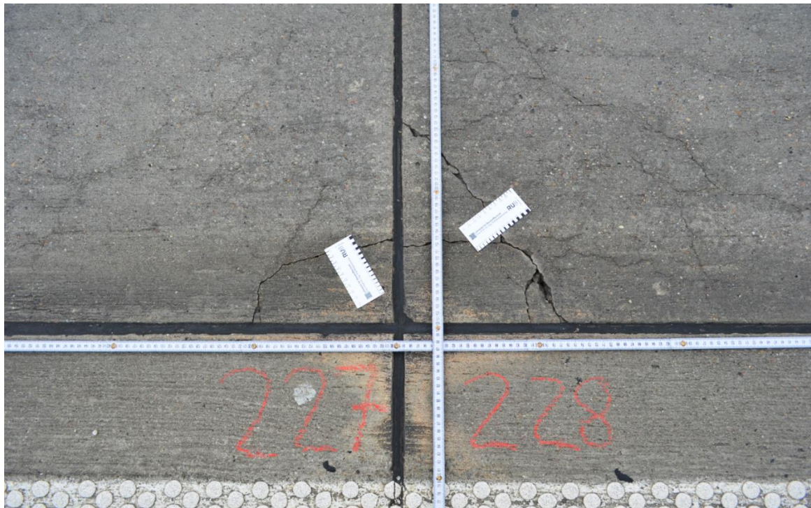
Abbildung 60: Beispielhafter Zustand eines Streckenabschnitts, der anhand beider Verfahren in Kategorie II bis III eingestuft wurde. Im Bereich der Fugen und Fugenkreuze traten ausgeprägte Risse und erste Eckabbrüche auf
