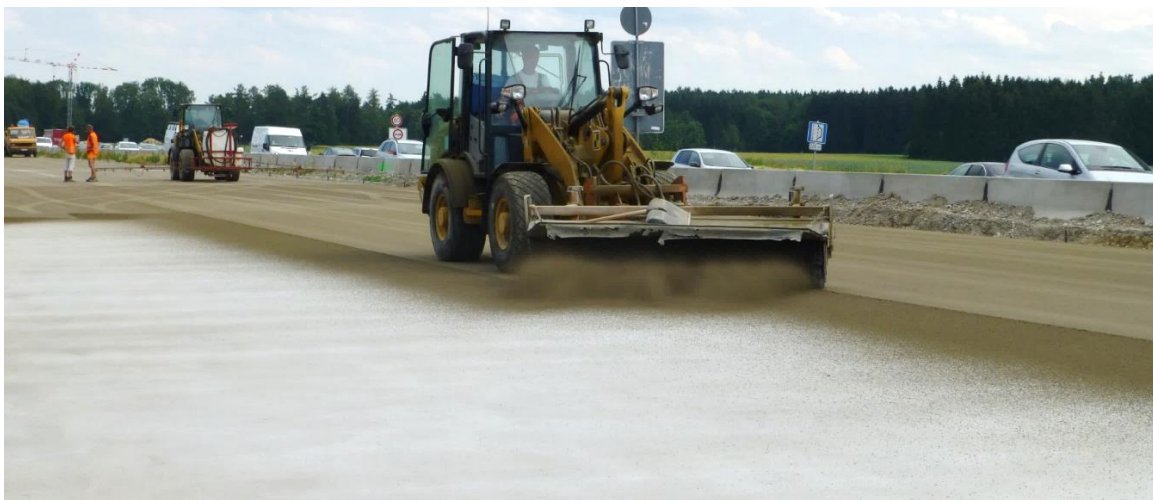
Abbildung 6: Ausbürsten des Oberflächenmörtels zur Herstellung einer Waschbetontextur
