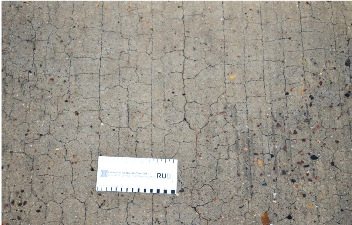
Abbildung 24: Ausgeprägte Netzrissbildung
