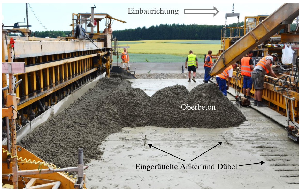
Abbildung 3: Einbau eines zweischichtigen Straßenbetons durch Gleitschalungsfertiger. Im Bild rechts der erste Gleitschalungsfertiger zum Einbau des Unterbetons, links der zweite Gleitschalungsfertiger zum Einbau des Oberbetons
