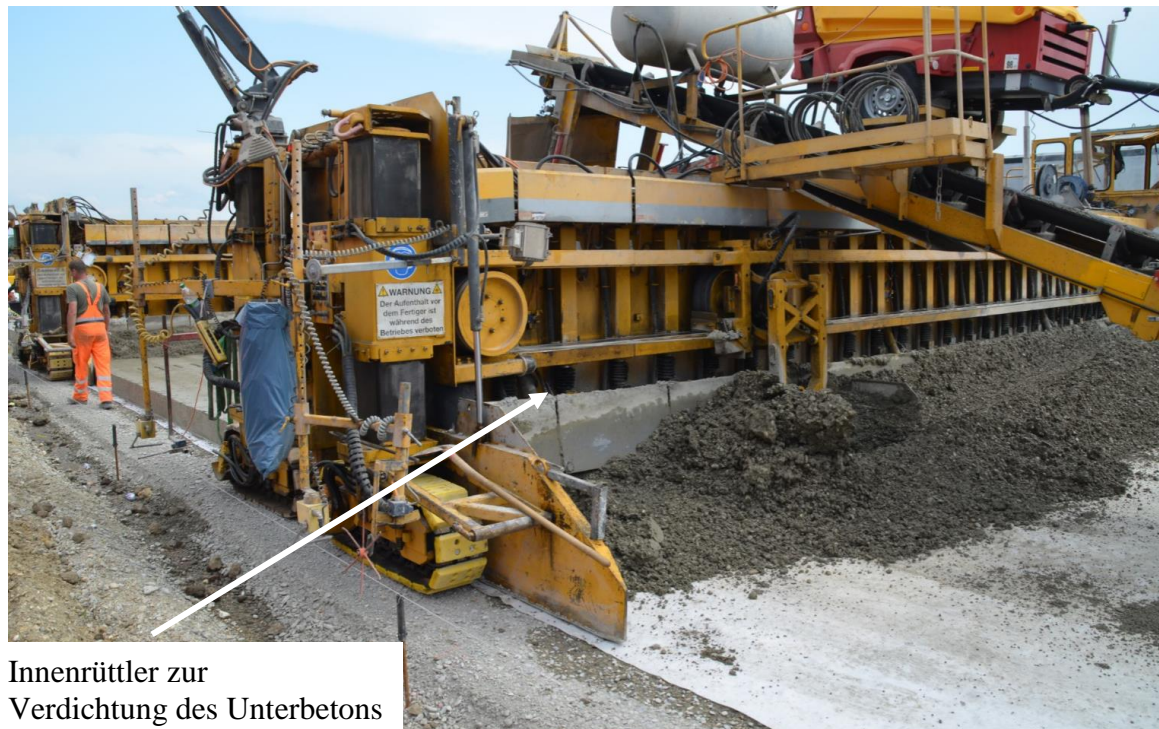
Abbildung 1: Einbau des Unterbetons durch den ersten Gleitschalungsfertiger
