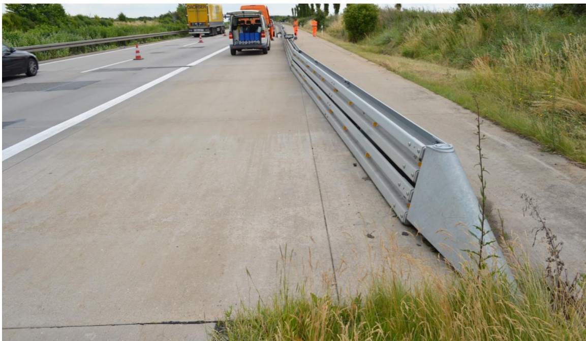
Abbildung 73: Streckenabschnitt F 33: Zustand des ungenutzten Anbaufahrstreifens: Längs-, Quer- und Tangentialrisse konnten auch hier festgestellt werden, Kantenschäden, Eckabbrüche oder Substanzverlust lagen nicht vor.
