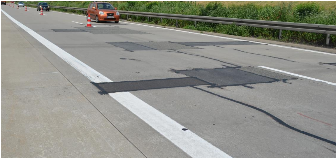
Abbildung 72: Streckenabschnitt F 33: Fortgeschrittene AKR-spezifische Schadensmerkmale (stark ausgeprägte Kantenschäden, Eckabbrüche und Substanzverlust) im 1. und 2. Fahrstreifen
