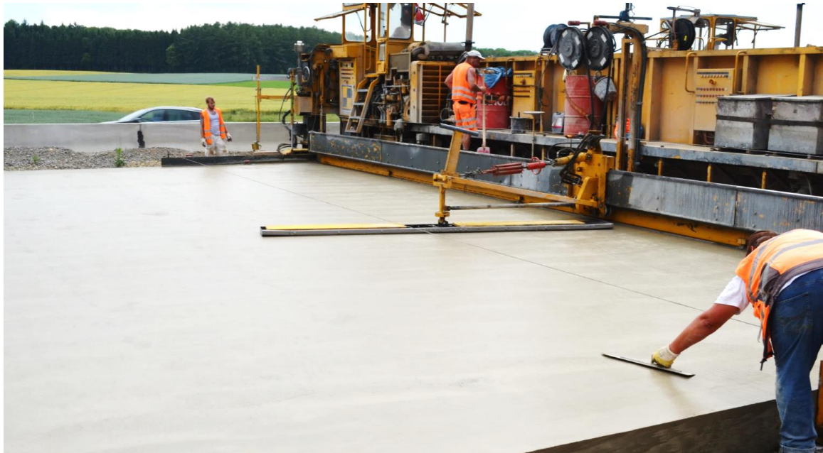
Abbildung 4: Abgegliche und geglättete Betonoberfläche hinter dem zweiten Gleitschalungsfertiger
