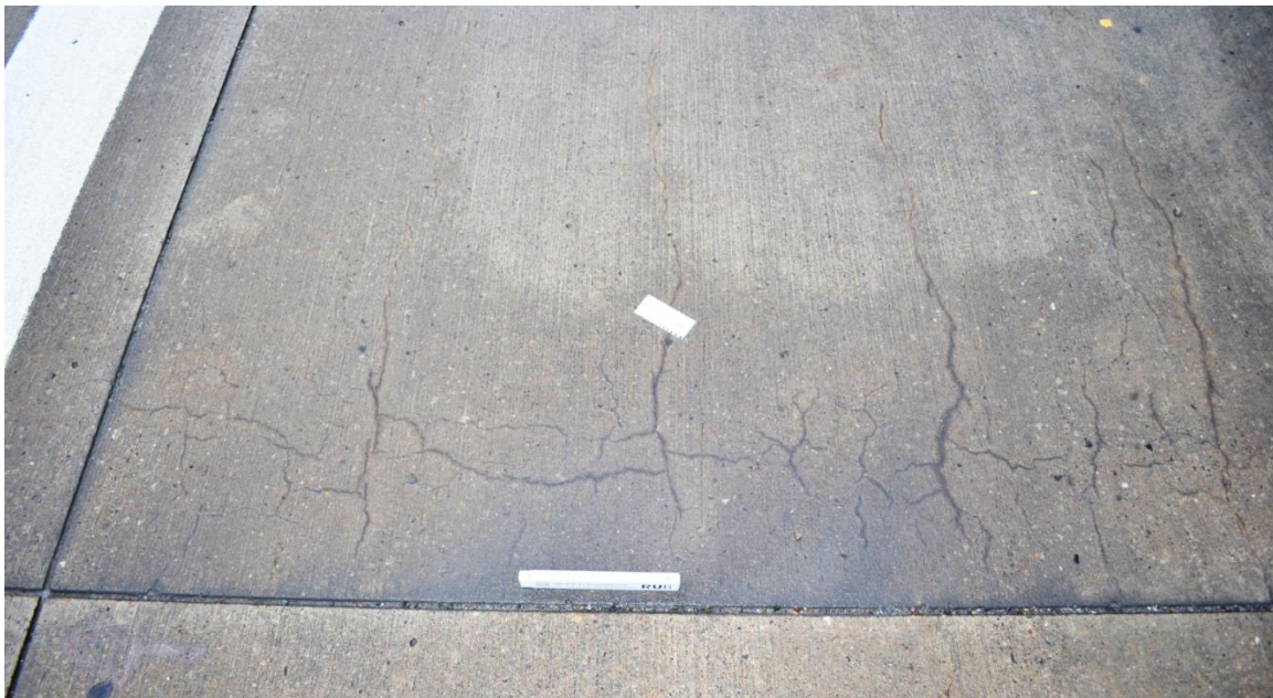
Abbildung 23: Längs- und Querrisse nahe der Quertugen
