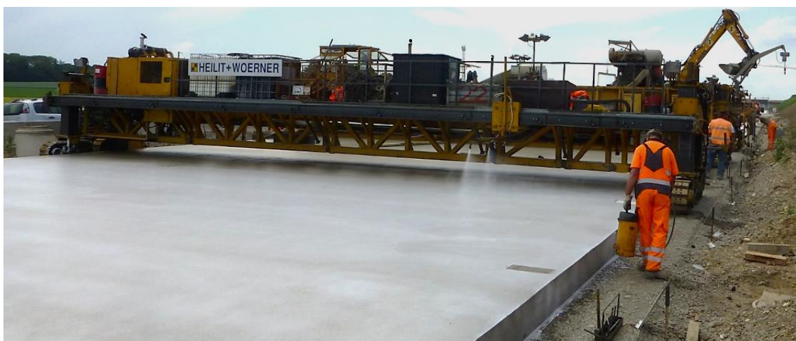
Abbildung 5: Auftrag eines Nachbehandlungsmittels auf die mattfeuchte Betonoberfläche
