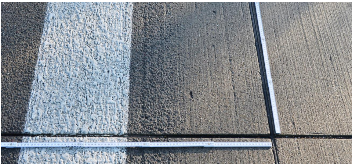
Abbildung 7: Texturierung einer Fahrbahndecke mit Waschbetonoberfläche im Bereich der Fahrstreifen (links) beziehungsweise mit Besenstrich (längs) im Standstreifen (rechts)
