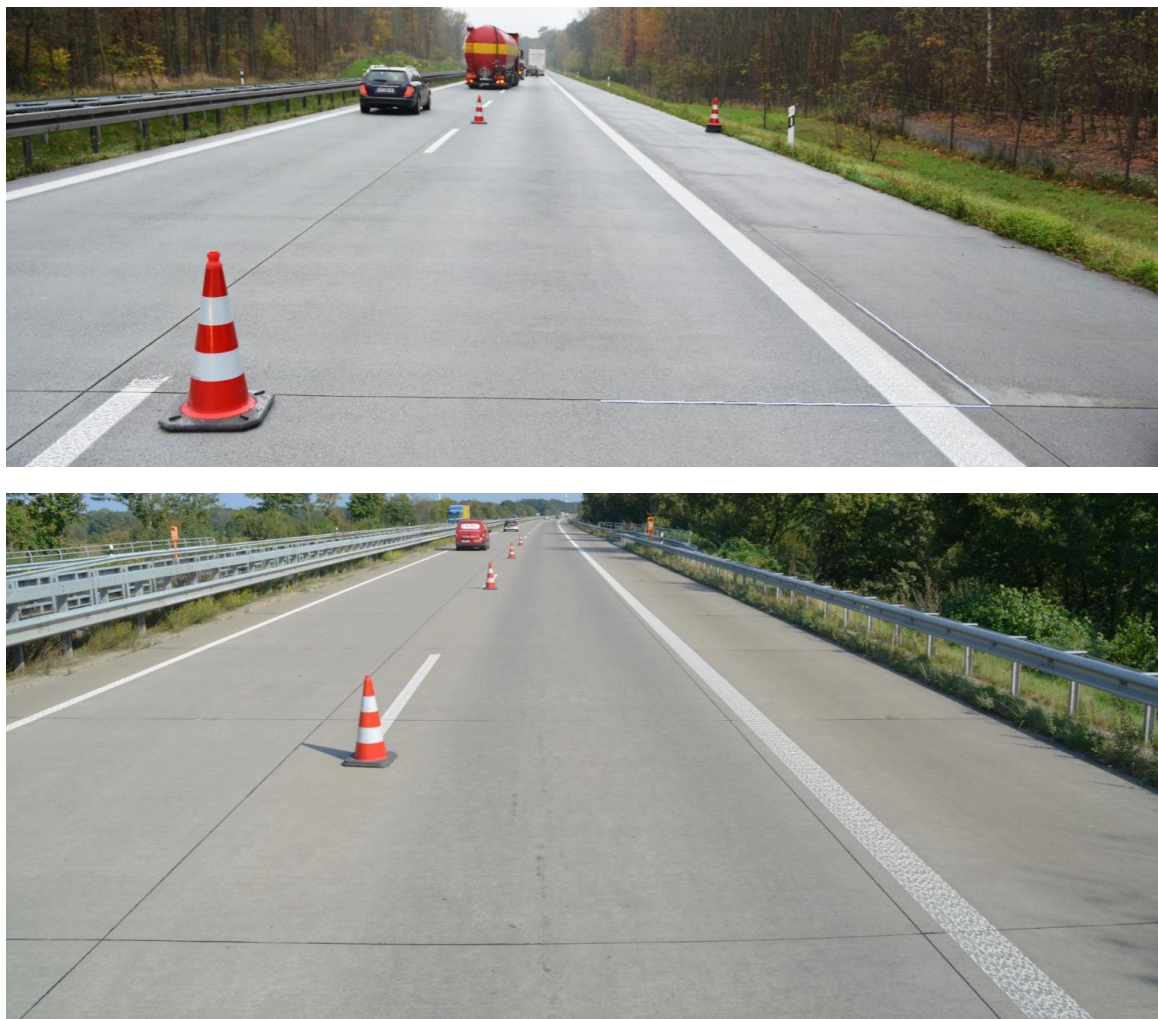
Abbildung 8: Günstige Fugenanordnung (oben) und ungünstige Fugenanordnung mit Lage der Längsfuge in der rechten Rollspur des Hauptfahrstreifens (unten)
