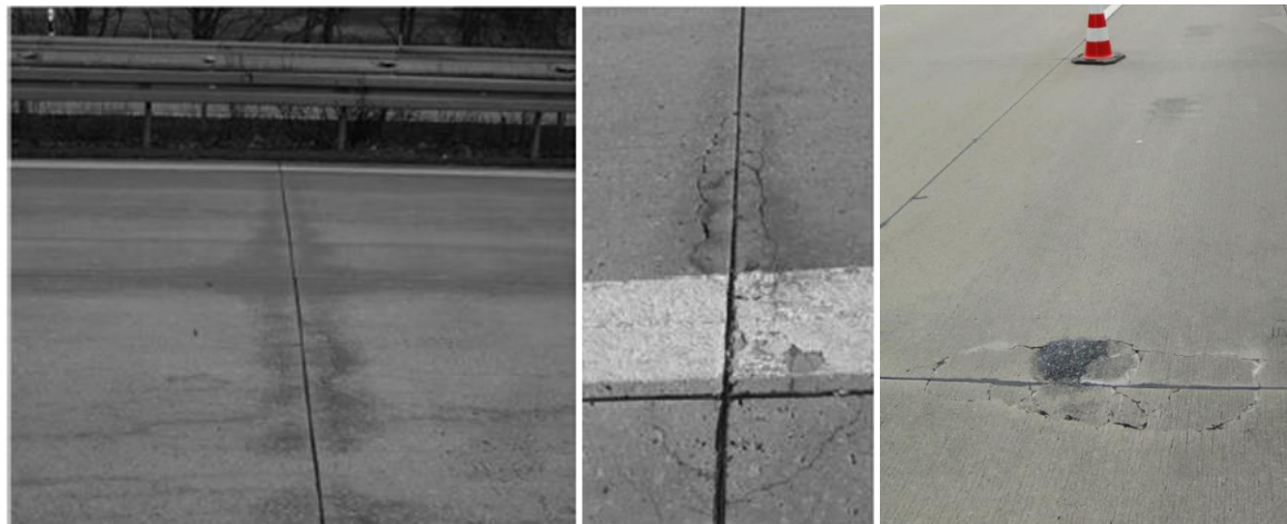
Abbildung 48: Beispiele für Erweiterte Schadenskategorie III (Bilder links aus [R 12])
